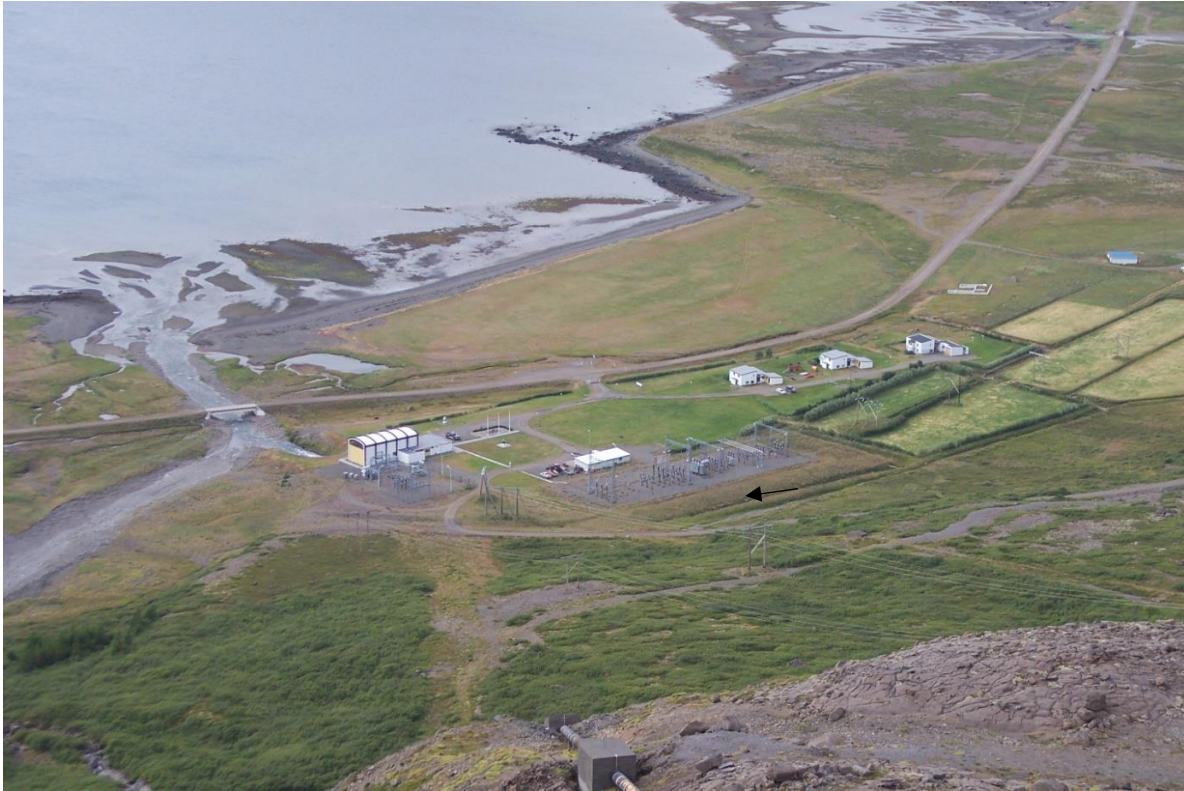
Mynd 6-4 Séð frá fjallsbrún við Mjólkurárfossa niður í Borgarfjörð. Stöðvarhús Mjólkár I og II er til vinstri. Byggt verður yfir neðra tengivirkið (til vinstri) og hið efra (til hægri) færast ofar eins og örin sýnir.
